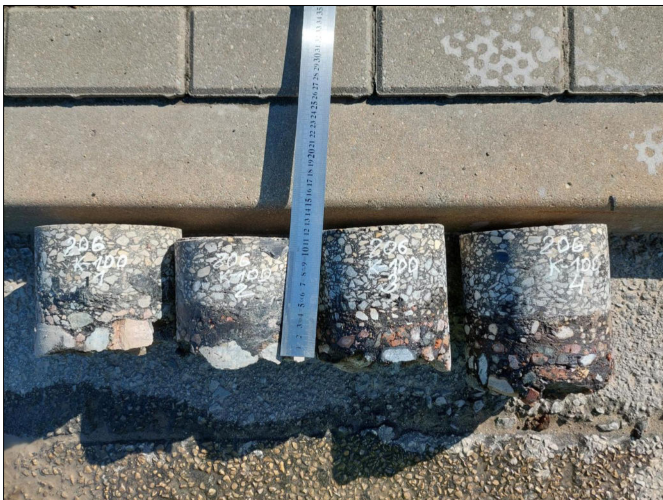
Pav. 5 Dangos kernai ties gręžiniu K-100 (Pk 00+268)
