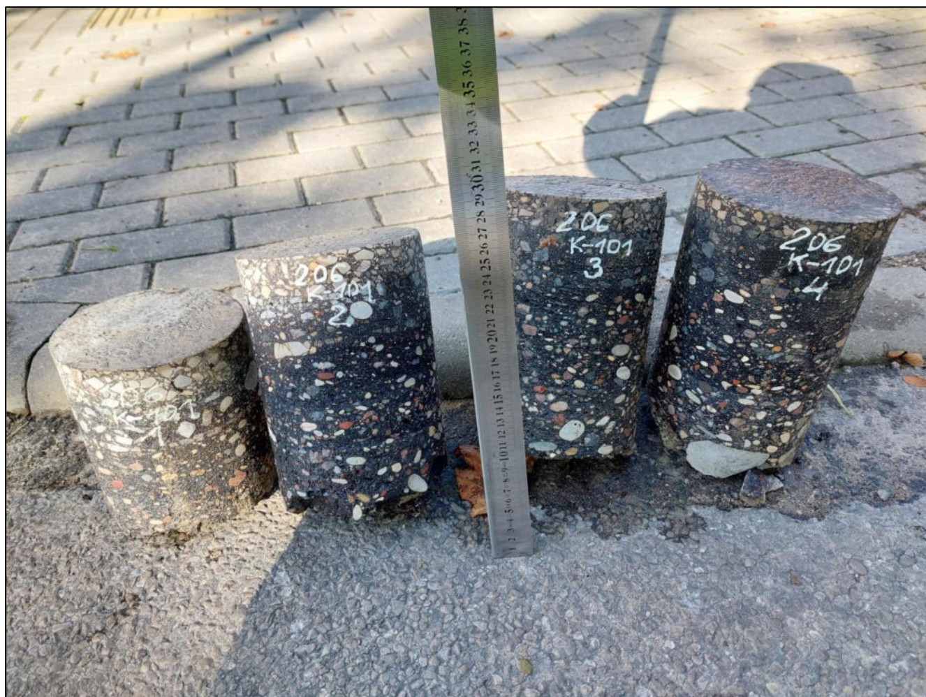
Pav. 4 Dangos kernai ties gręžiniu K-101 (Pk 00+135)
